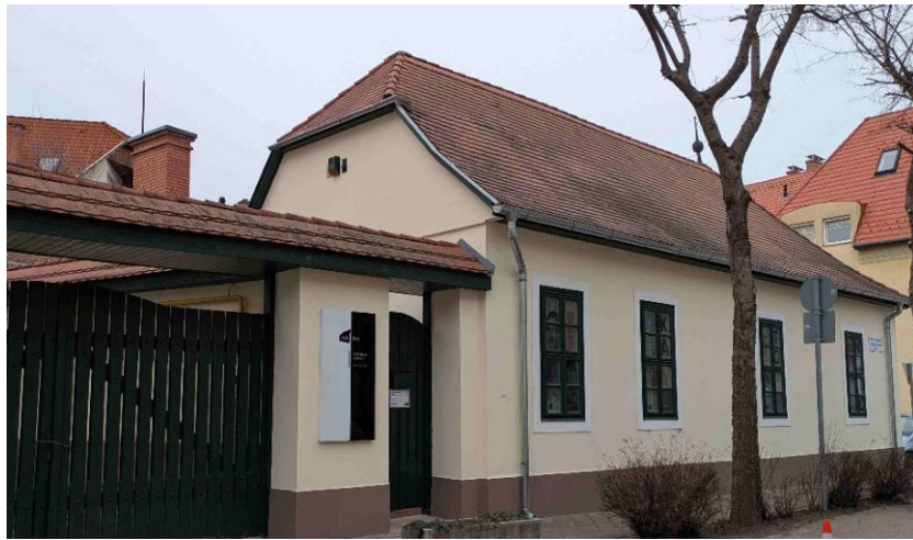
A felújított épület
